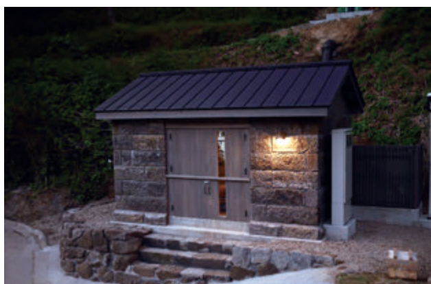
石積みみの発電所建屋
