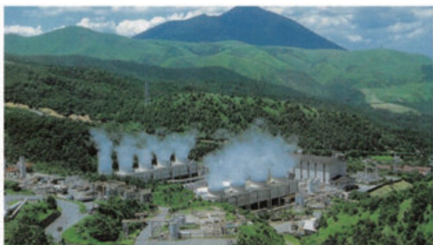
地熱発電所の冷却塔から立ち上る白煙の様子（八丁原地熱発電所） （出典：九州電力株式会社「九州電力の地熱発電所」パンフレット）
