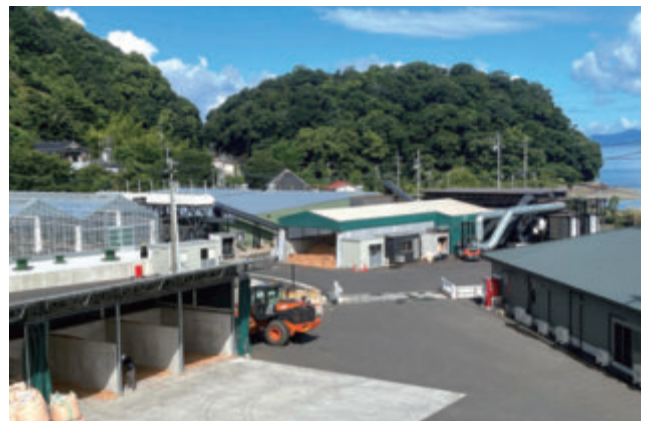
木質バイオマス熱電併給プラント及び周辺施設
