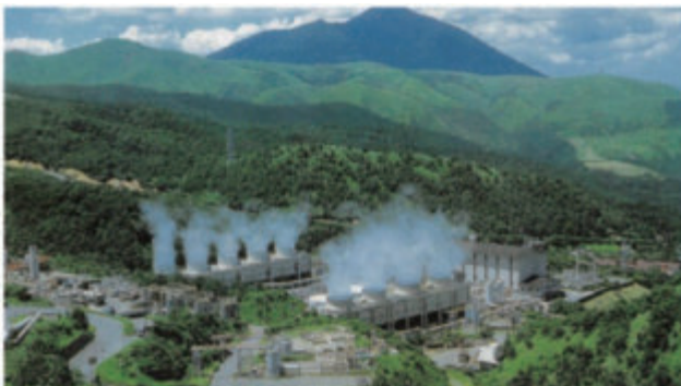
地熱発電所の冷却塔から立ち上る白煙の様子（八丁原地熱発電所） （出典：九州電力株式会社「九州電力の地熱発電所」パンフレット）
