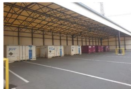
コンテナ積み替え施設(東京タ)
