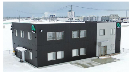
玄関にヒートパイプを施工
