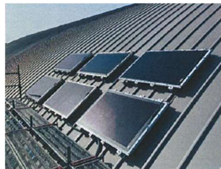
体育館・アーチ屋根
